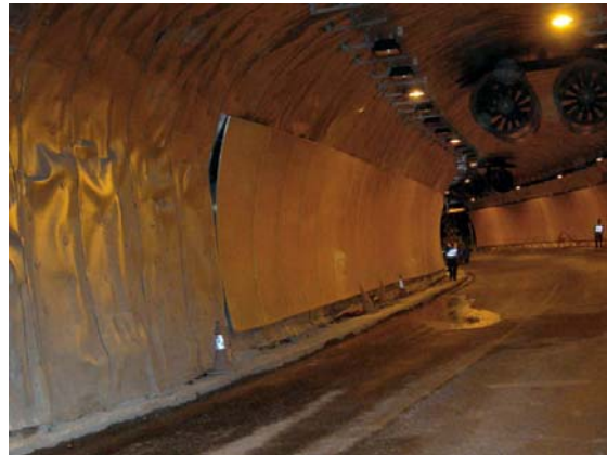
Ejecución del panelado
